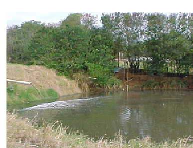
Transição da lagoa anaeróbica para a facultativa
